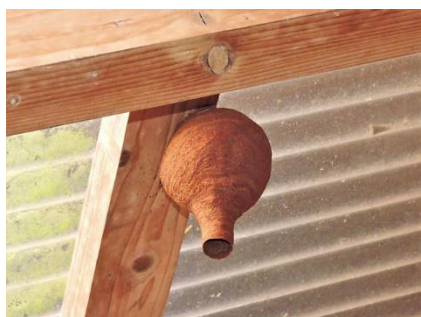
九日夕方（第一期工事完了）
